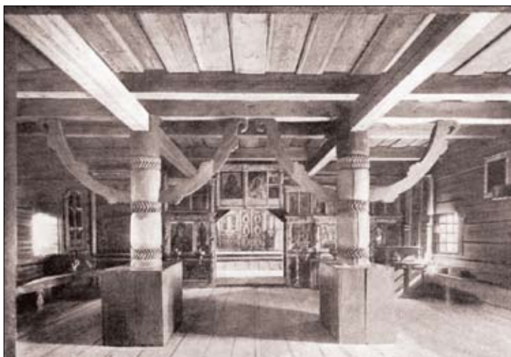
Общий вид трапезной Благовещенской церкви. Фото А.В. Лядова. ЦГРМ. 1925 г. МАА
