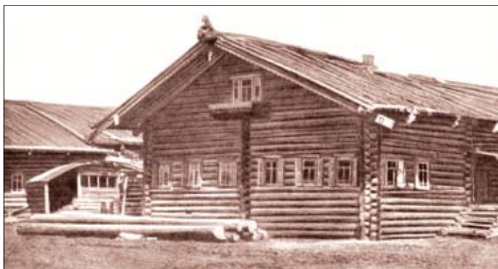
С. Кырканда, Архангельская обл. Изба. Фото из коллекции К. Ф. Некрасова. МАА
