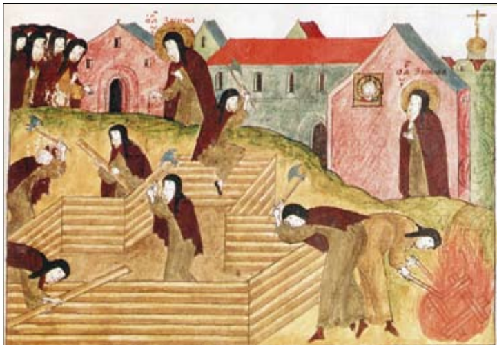
Строительные работы в монастыре
