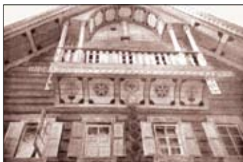
Д. Лахново (близ Шуньги), Заонежский р-н Карелии. Дом Латаковых 1860-х гг. «Выход» на лицевом фасаде дома. Фото Л. С. Залесской 1939 г. МОССА
