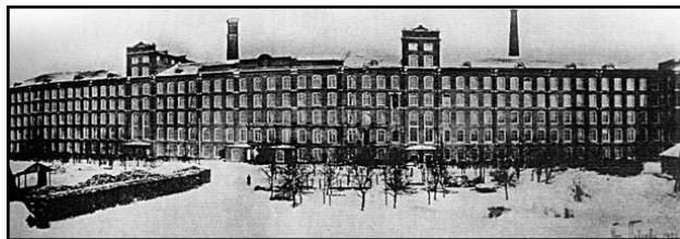
Прядильный корпус Раменской бумагопрядильной и ткацкой фабрики промышленного и торгового Товарищества «П. Малютина сыновей». Фото 1900 г.
